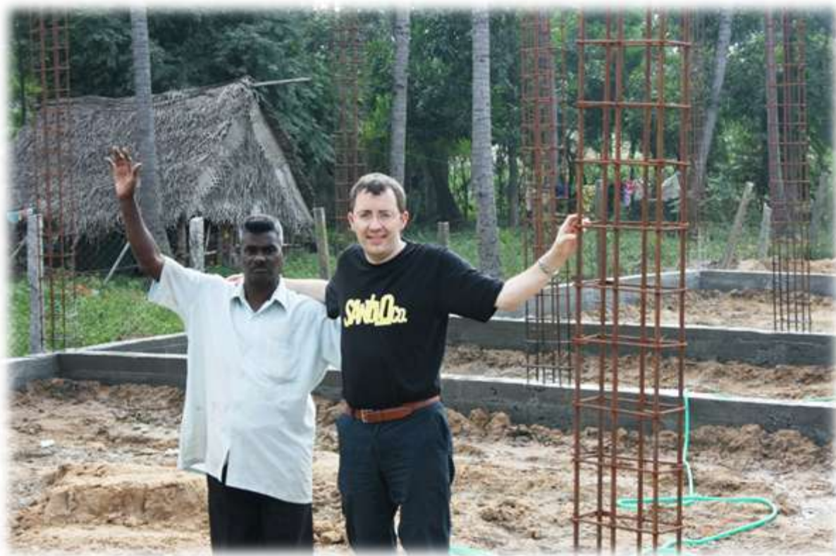
Bruder Samuel mit mir auf dem Baugrund des neuen Waisenhauses
