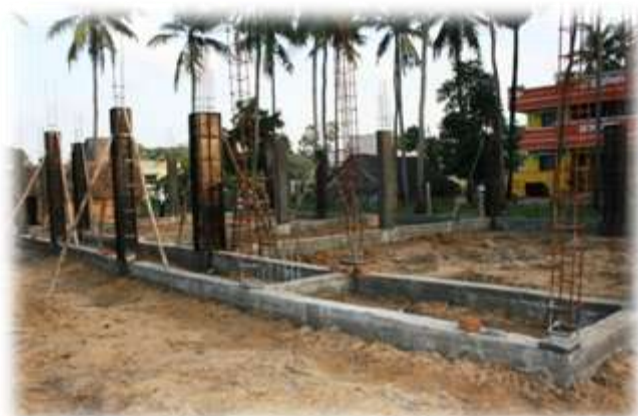
Die Baustelle kurz vor unserer Abreise
