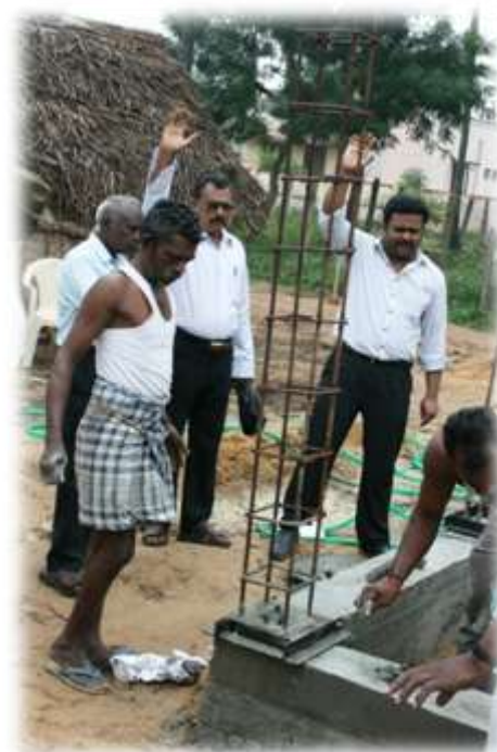
Die Arbeit geht voran
