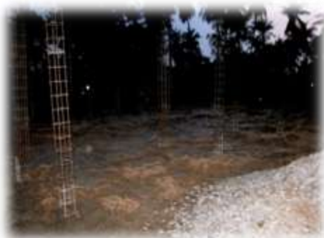
Die Baustelle bei unserer Ankunft
